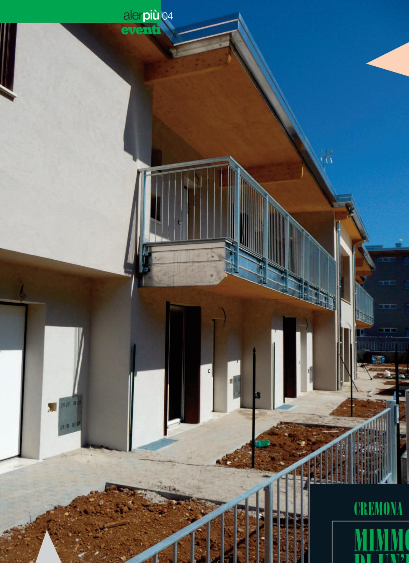
**S**ono 29 i nuovi alloggi in fase di assegnazione a Lonato. Si tratta di due fabbricati, in via padre Marcolini, con una particolarità unica nel comparto degli edifici di nuova produzione: tutta la struttura, compresi i solai e i vani scale, sono in legno. È noto che il legno nel settore delle costruzioni nell'ultimo ventennio ha svolto un ruolo molto importante, perché naturale, rinnovabile, compatibile e sostenibile.
